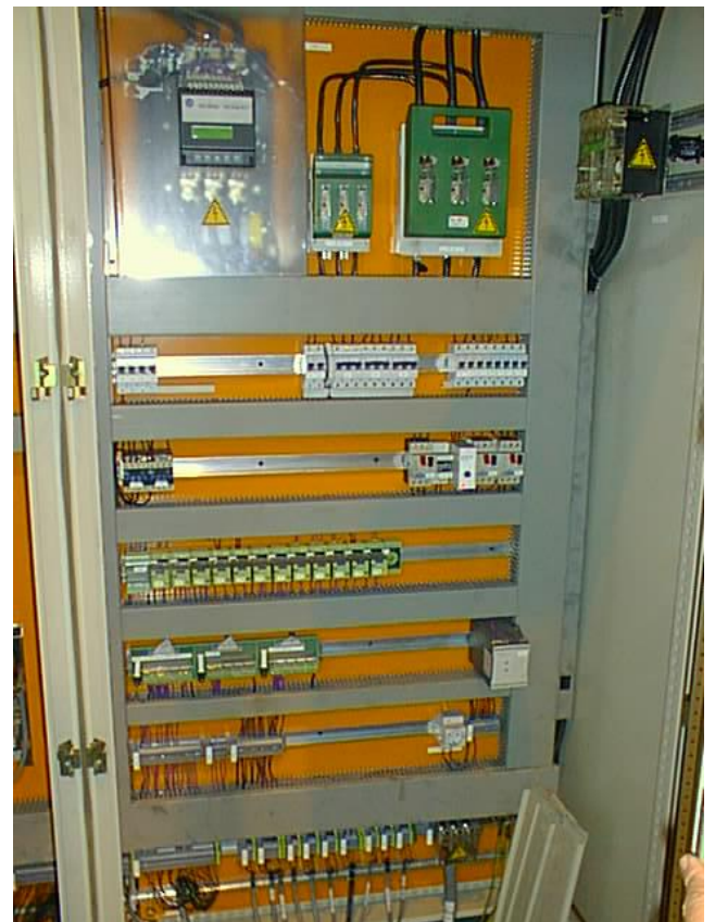
Bild 11: Die ganze Elektrik wurde komplett erneuert, nach den Vorschriften des Endkunden.
