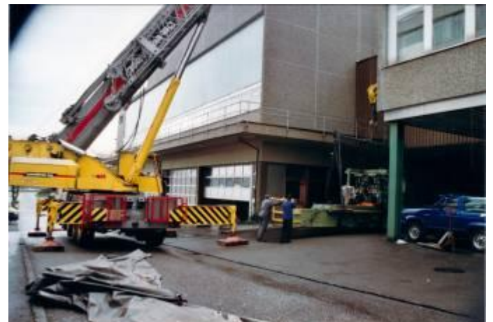
Bild 40: Eine schräge Einfahrt bei einer so schweren Maschine braucht grosse Vorsicht und ein gutes Zusammenspiel der Leute, die den Transport durchführen.
