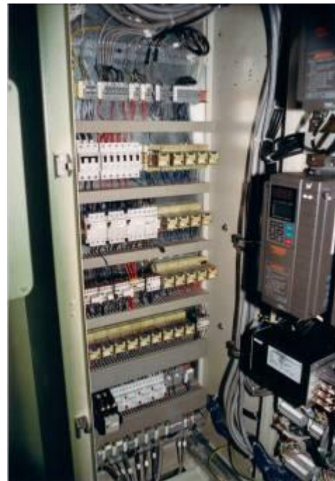
Bild 21: Im ganzen Projekt war der elektrische Teil von Beginn an integriert.
