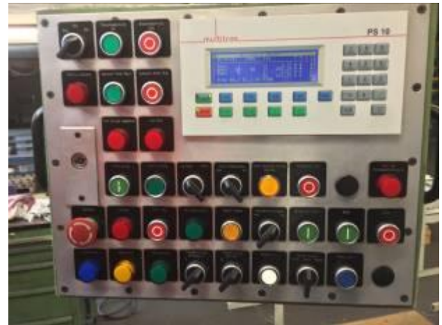
Bild 24: Die CNC Steuerung mit der Bedienung war fast 20 Jahre in Betrieb.
