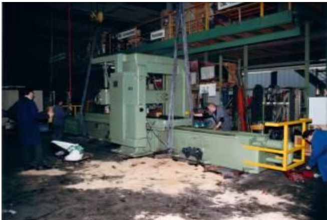
Bild 27: Der Verlad der Maschine konnte gut mit den 2 x 10 Tonnen Hallenkränen durchgeführt werden.
