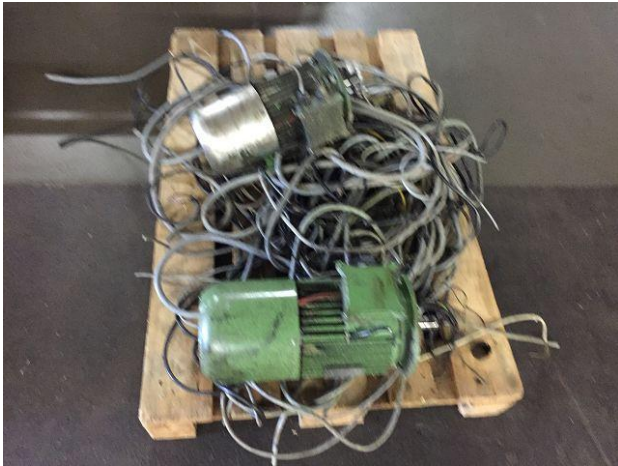
Bild 5: Alle Kabel und die alten Motoren ersetzt.
