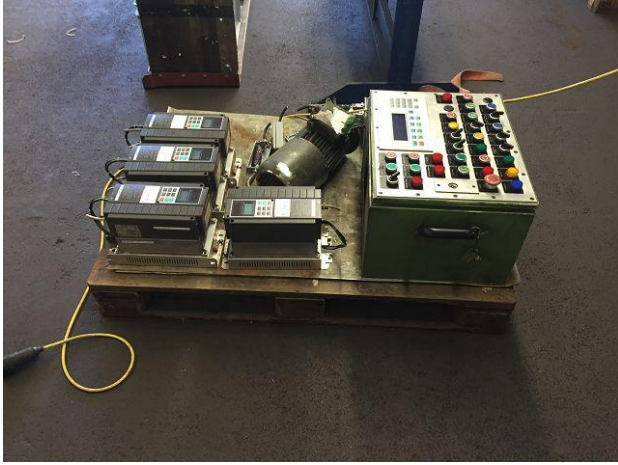
Bild 4: Sämtliche alte Ware wurde demontiert.
