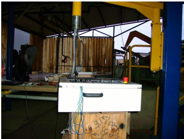
Bild 5: das Panel wird am selben Ort befestigt, wo die alte, schon 20 Jahre CNC Steuerung, war.
