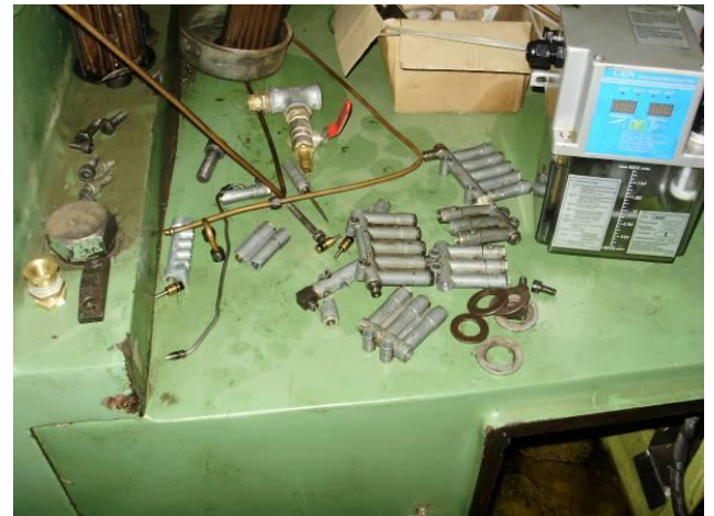
Bild 39: Viele defekte Schmier Teile wurden ersetzt.
