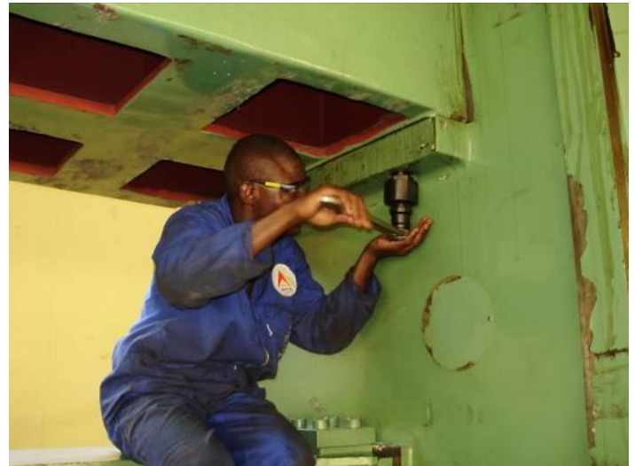
Bild 11: Mit der 55 mm Nuss und Rätche die Schrauben reindreihen ist ja eines, doch noch Gewinde im Dach nachschneiden ist dann anstrengend.
