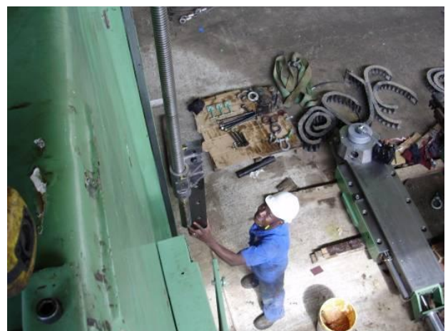
Bild 13: Bei der Montage ist Höhenangst nicht geeignet..
