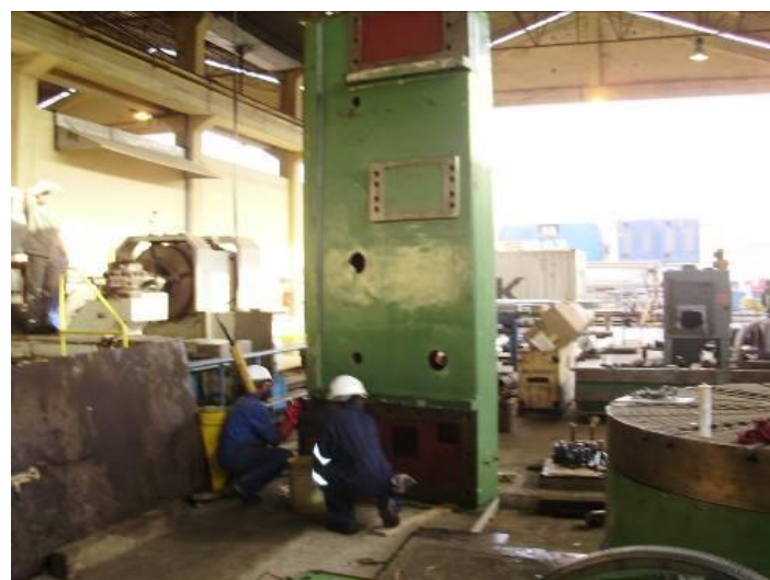
Bild 6: Er steht, war aber einiges an Arbeit, weil der Kran-Haken nur auf 4.8 Meter geht und der Seitenständer 3.8 Meter hoch ist, abzüglich des Balkens, den man benötigt zum aufstellen.
