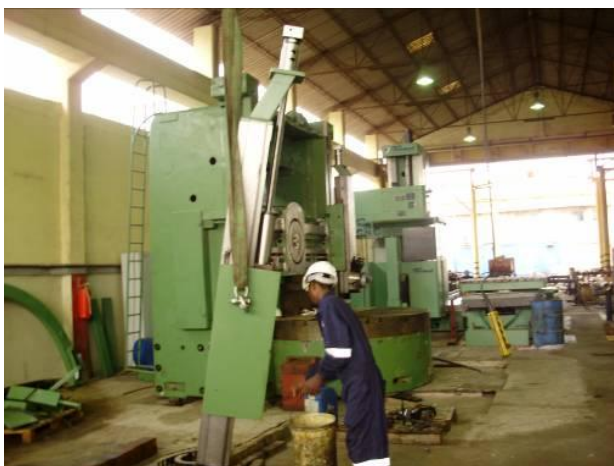
Bild 18: Das letzte, schwere Teil der Maschine wird noch heute montiert. Es war aufwendig, das lange Element gerade im Kran hängend zu haben.
