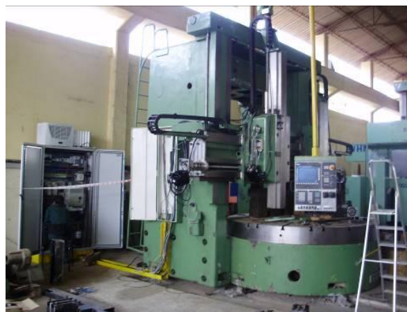
Bild 27: Die Maschine nimmt Formen an. Bald sind alle neuen Kabel eingezogen. 2 Achsen laufen schon. Wir reisen jetzt zurück nach 20 Tagen und kommen noch einmal in ca. 2 Wochen ab Mitte November, denn wir müssen ja noch testdrehen und schulen.
