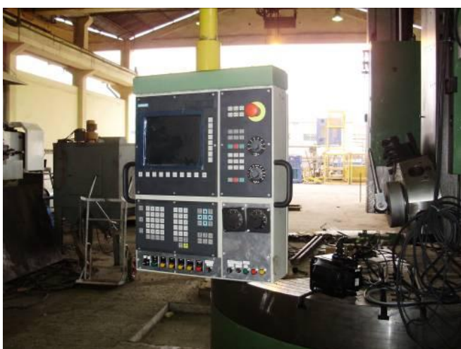
Bild 25: Festlegungen der CNC Ergänzungen. Schrank fertig machen und testen.
