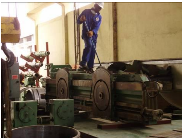
Bild 3: Der Querbalken war auch komplett gegen den Rost geschützt. So wurde die Maschine in einem Container, der von oben geöffnet werden konnte, von Dänemark nach Angola Luanda transportiert.
