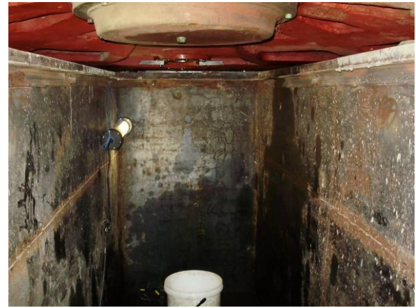
Biid 32: Der Schacht unter der Maschine.
