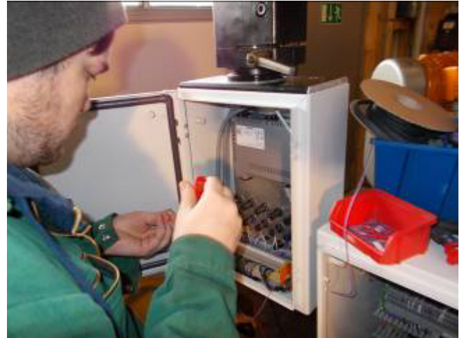
Sven Widmer beim Verdrahten des HMI Panels. WU5130r
