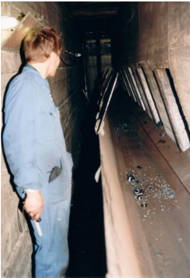
Bild 4: Unter der Maschine ist der Späneschacht. Mit 220 KW und dem grossen Drehmoment werden hier Späne so gross wie Flacheisen, abgetragen.
