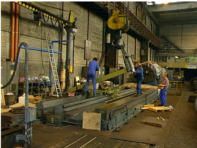
Bild 11a: Montage der Wiap Sonderfräsvorrichtung.
