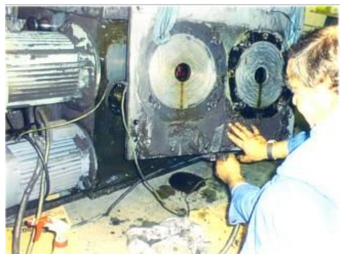
Bild 13: Der ganze Kreuzschlitten der Walzendrehmaschine war in einem sehr schlechten Zustand.
