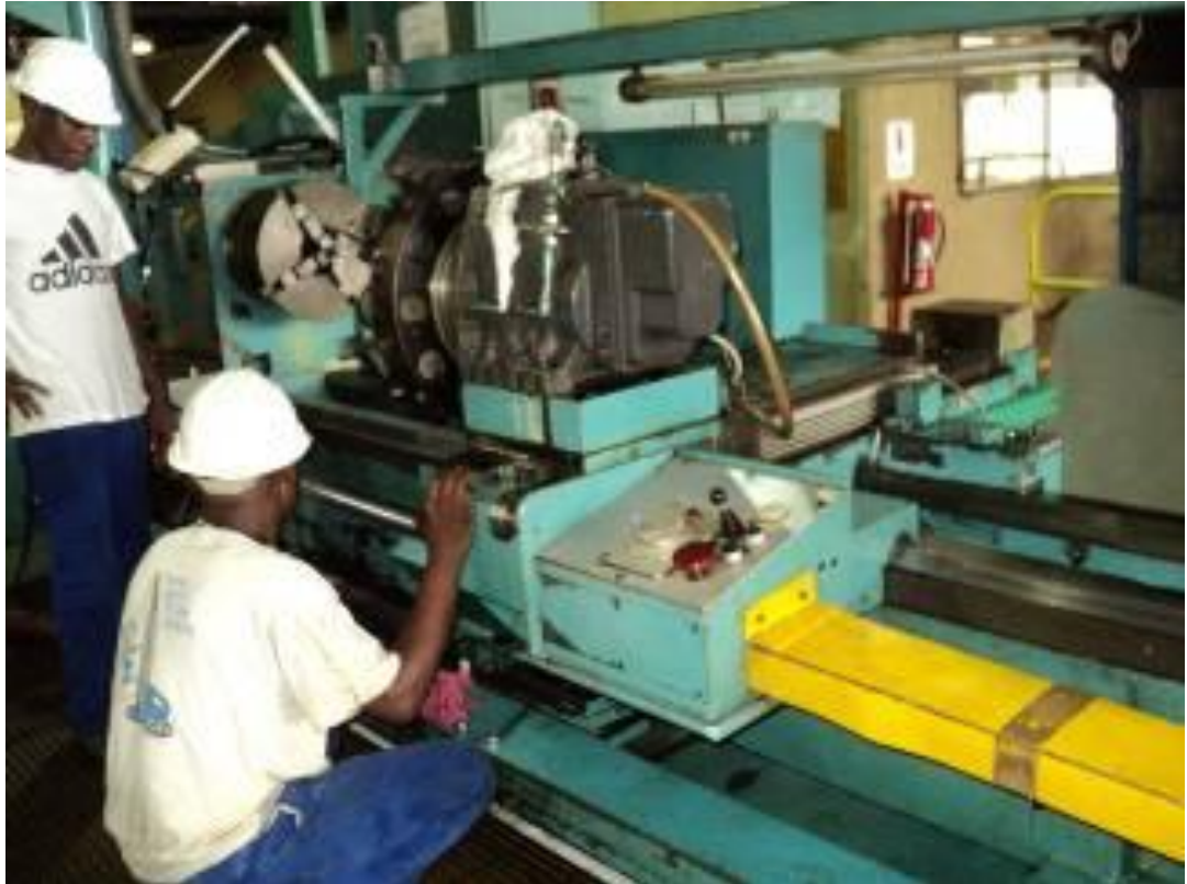
Bild 9: Die Monteure bereiten die Demontage des ganzen Kreuz Schlittens vor.
