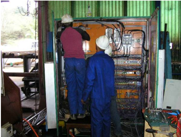
Photo 20: Hier baut man den alten Siemens Regler aus.
