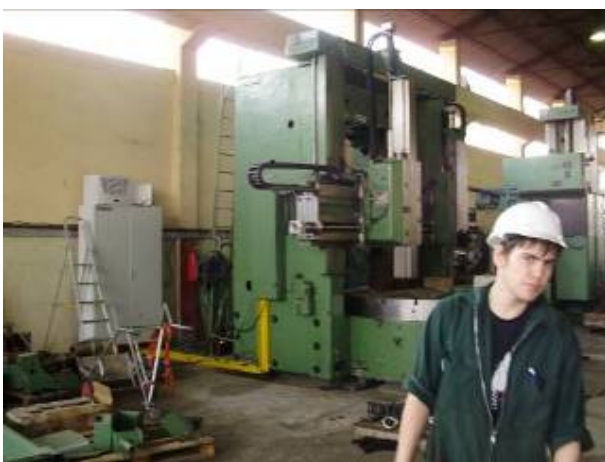
Start der Verkabelungen. Sven Widmer WU_240_220
