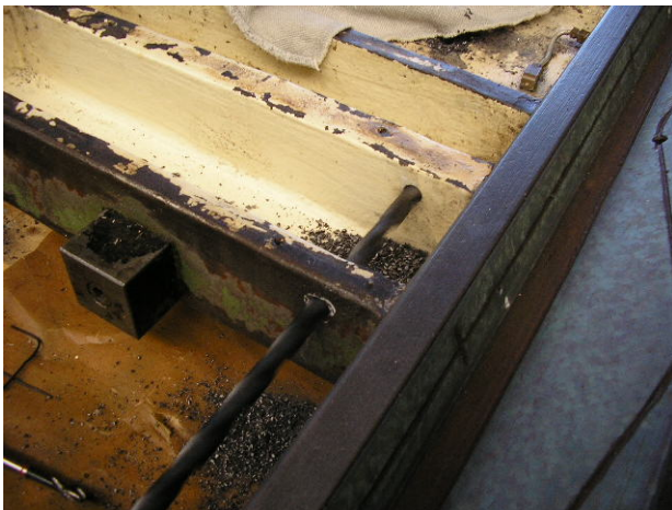
Photo: Man bohrt so, dass man die Schmierleitungen aus dem Spänebereich montieren kann. Hier unten gibt es dann ein Belchdeckel.
