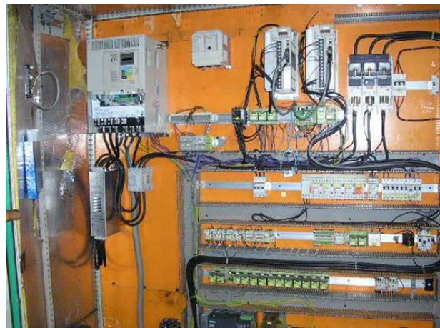
Photo 8: Alles, was Kabel war, weg. (Wir hatten eine Idee, Wireles). Die Fehlerquellen waren zu gross, die Maschine hatte so viel drin wie Messen, Bruchüberwachung Angetrieben Werkzeuge, C Achse. Aber man brauchet es nie. Die Maschine war voll nur mit Rohrdrehen belegt, darum haben wir für den Unterhalt nur noch das Minimum vor drin zu haben.
