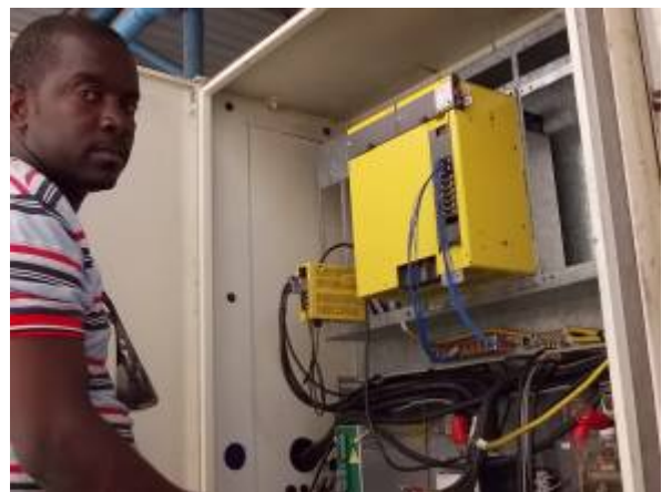
Bild 5: Unser, in der Ausbildung befindlicher, Unterhaltsmann Alberto bei der Vorbereitung des Ausbaus. WU_232_50
