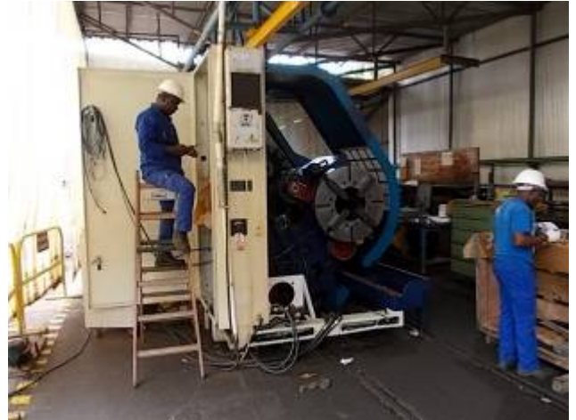
Bild 24: Alberto bereitet den Einbau vor. WU_232_180
