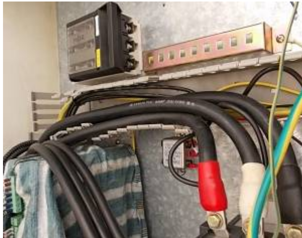
Bild 27: Das Absicherungssystem wird verbessert. Keine Drähte ohne Absicherung. WU_232_210
