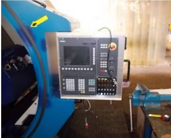
Bild 38: Wir werden bald die ersten Test's mit externen 24 Volt machen. WU_232_320
