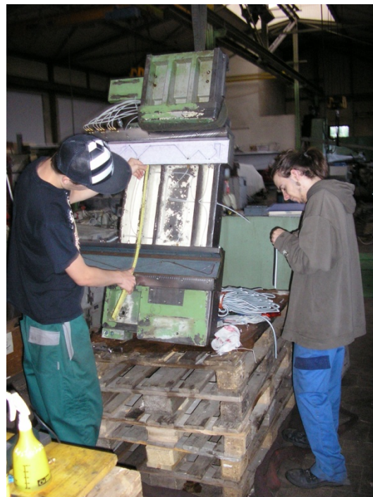
Bild 18: Der richtige Gleitbelag ist das Herz der Arbeit. Die Wiap hat praktisch mit allen gearbeitet und setze den jeweilig Nötigen ein. Vor allem, dass der Stick-Slip Effekt= Haftgleiteffekt, sich nicht negativ auf die Präzision der Werkzeugmaschine auswirkt. Die Wiap hat bei problematischen Sachverhalten noch ein Luftabhebesystem als Abhilfe. Dann wird immer beim Vorschub mit Luft der Schlittendruck reduziert.
