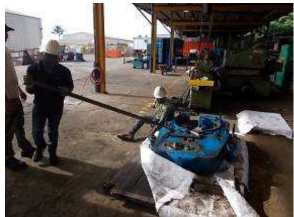
P64) Mit grossen Verlängerungen musste ein Teil der Schrauben geöffnet werden.
