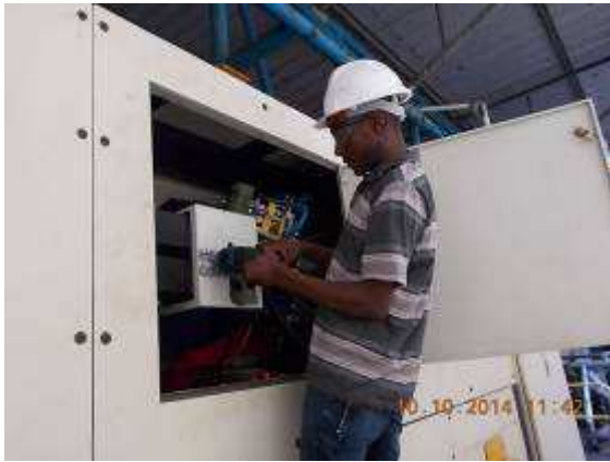
P11b) Yoba beim Klemmenbox herrichten der Z Achse.
