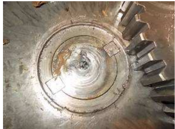
P63) Einige Schadstellen.
