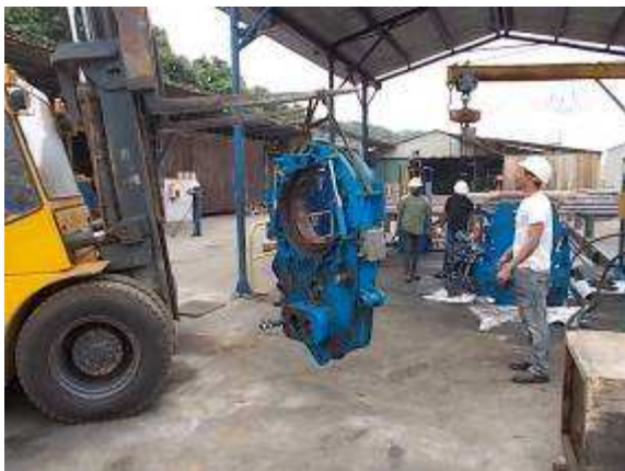
P61) Das Innenelement wird ausgebaut zum zerlegen.
