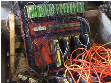
Bild 2.2-2 Alte ausgebaute Steuerung
