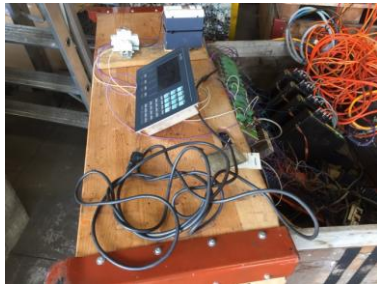
Bild 2.2-1 Alte ausgebaute Steuerung
